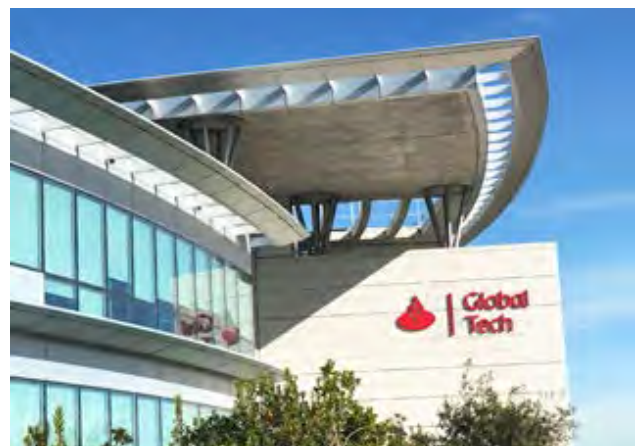
Edificio Athambra, Boadilla del Monte, España
