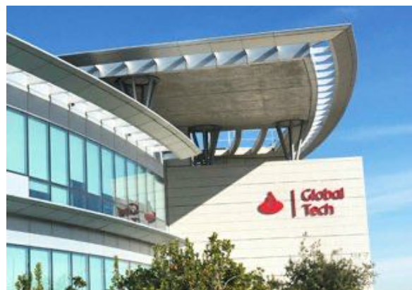
Edificio Alhambra. Boadilla del Monte
